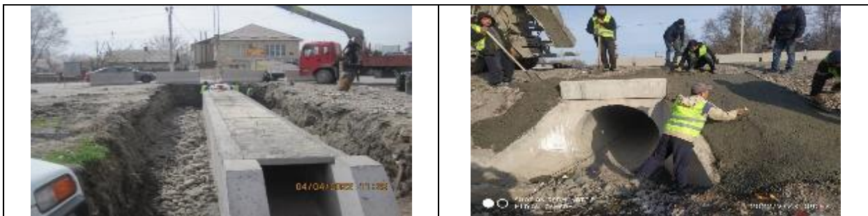
Рисунок 14 Строительство водопропускных труб
