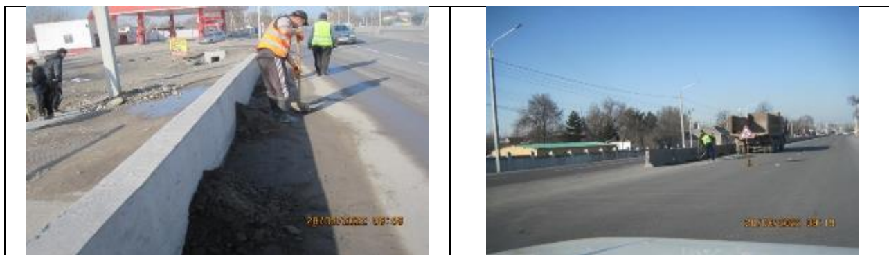
Рисунок 28 Очистка парапетов от земляных отходов и вывоз отходов с дороги
