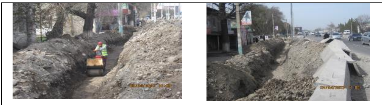
Рисунок 15 Установка придорожных водопропускных лотков на участке км 7,4
