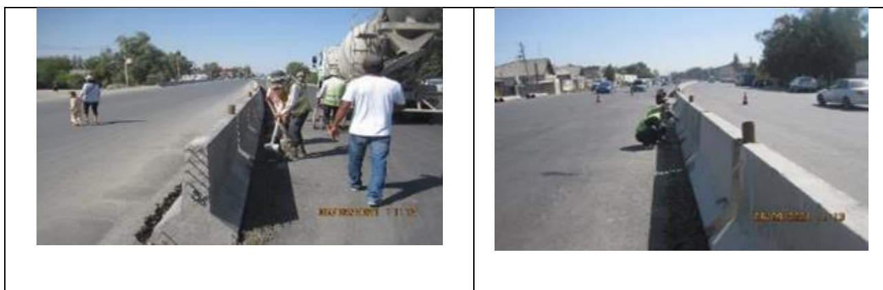
Рисунок 30 Работы по бетонированию канав на проездах между парапетами
