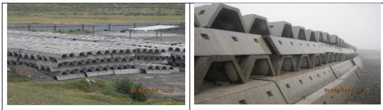
Рисунок 19 Заготовленные железобетонные конструкции
