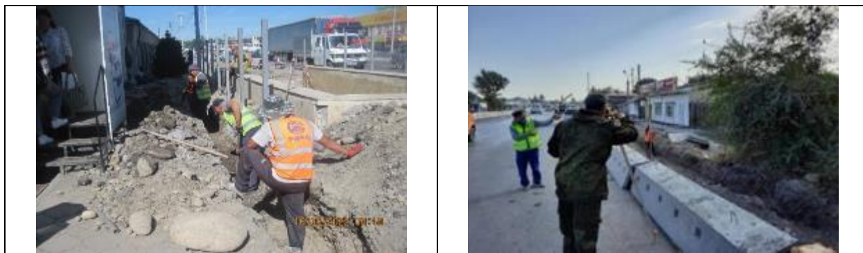
Рисунок 4 Строительство водопропускных лотков
