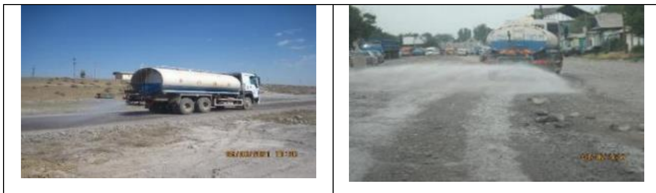
Рисунок 27 Проведение работ по пылеподавлению (гидроорошение). Дорога на производственную площадку и на участке строительства дороги в с. Военно-Антоновка
