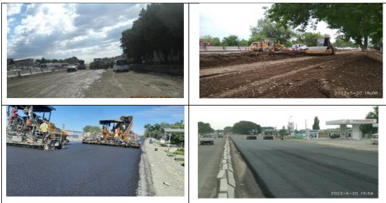
Рисунок 13 Укатка, уплотнение грунта и асфальтирование дорожного полотна на участке 7.4 км.
