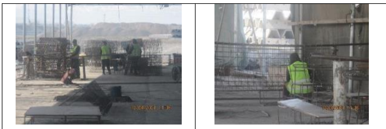
Рисунок 40 Изготовление арматурных сварных сеток, каркасов для изготовления железобетонных конструкций,
