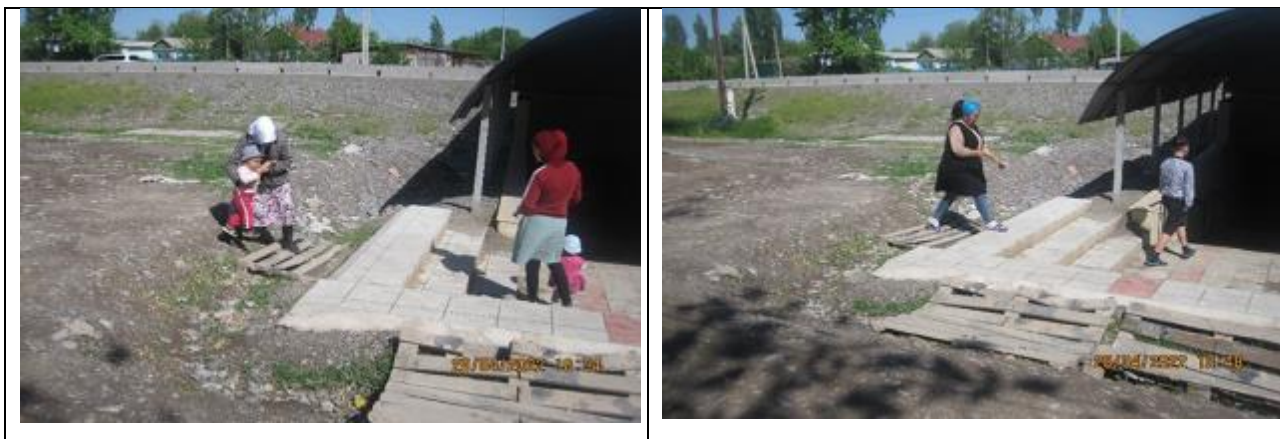
Рисунок 33 Нарушения возле подземного перехода у школы в с. Новониколаевка
