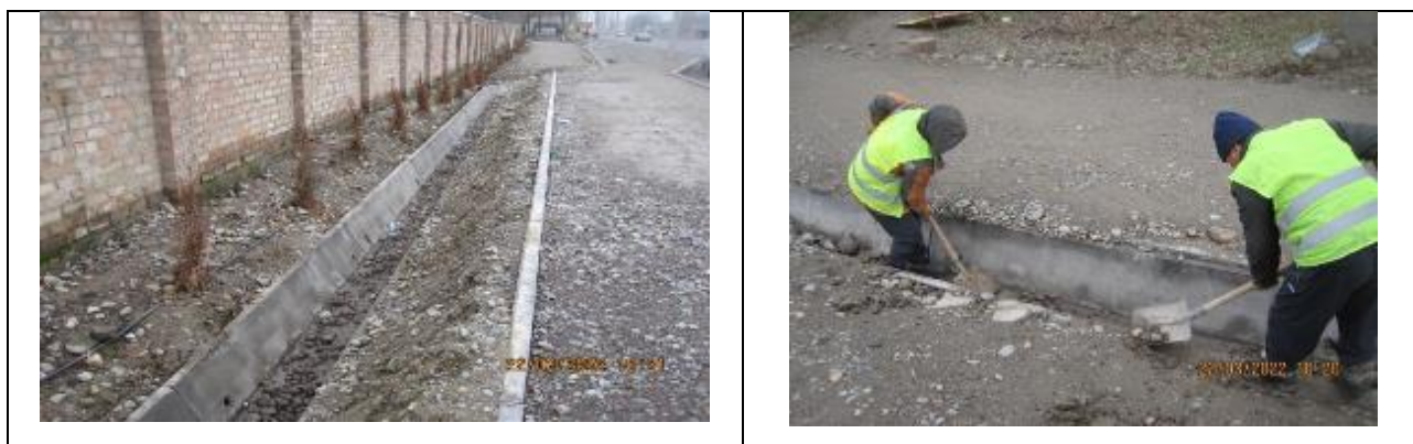
Рисунок 29 Очистка водопропускных лотков
