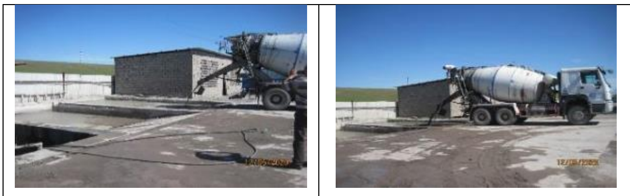
Рисунок 42 Промывка автобетоносмесителей.
