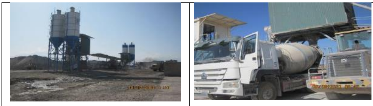
Рисунок 22 Заправка бетоном бетоносмесительной машины
