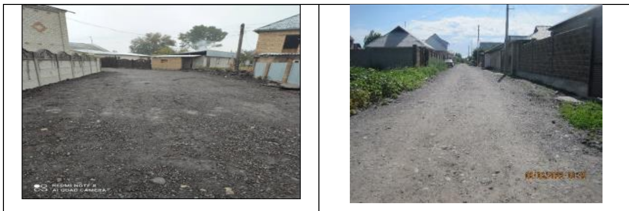
Рисунок 56 Отсыпка старого асфальта на внутренние дороги с. Военно-Антоновка
