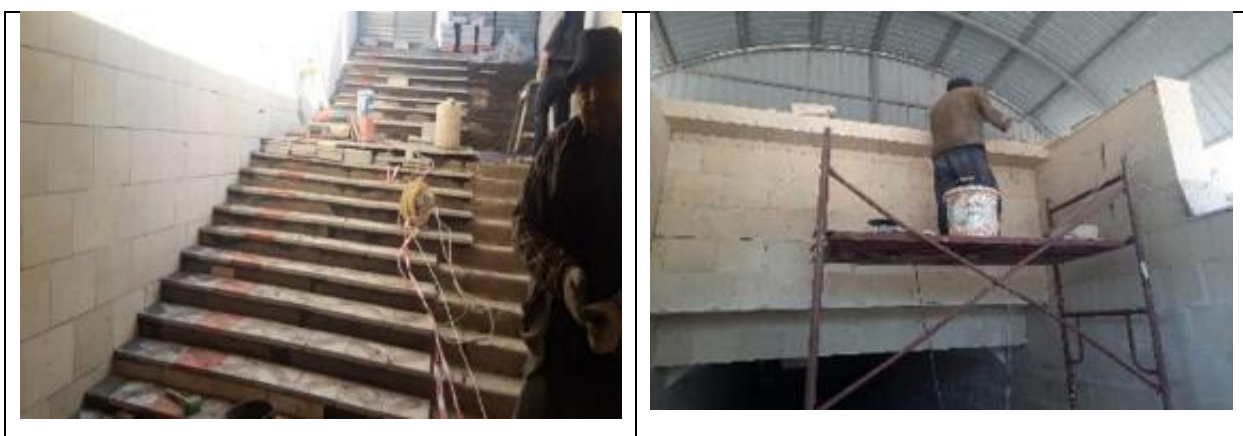
Рисунок 9 Работы по завершению строительных работ в подземных переходах
