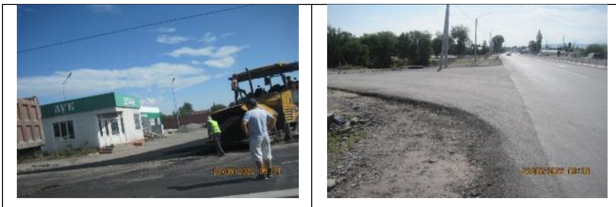
Рисунок 7 Укладка асфальта на съездах на примыкающие к трассе улиц в с. Беловодское
