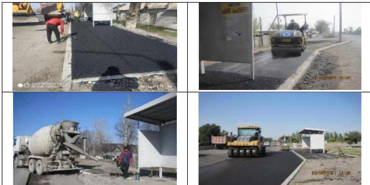
Рисунок 3 Асфальтирование остановочных площадок.
