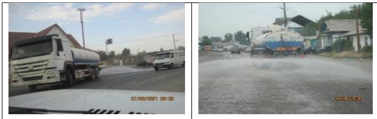
Рисунок 16 Проведение работ по пылеподавлению (гидроорошение). Дорога к производственной площадке и на участке строительства дороги
