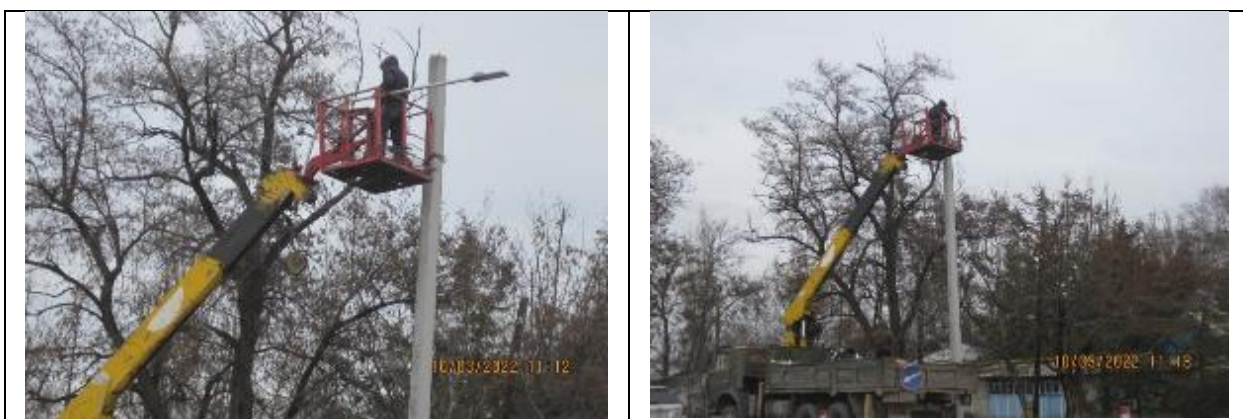
Рисунок 8 Проведение работ по уличному освещению. Установка светильников
