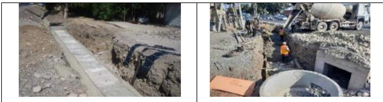
Рисунок 5 Установка придорожных водопропускных лотков и переездов к частным домам и на примыкающие к трассе улицы
