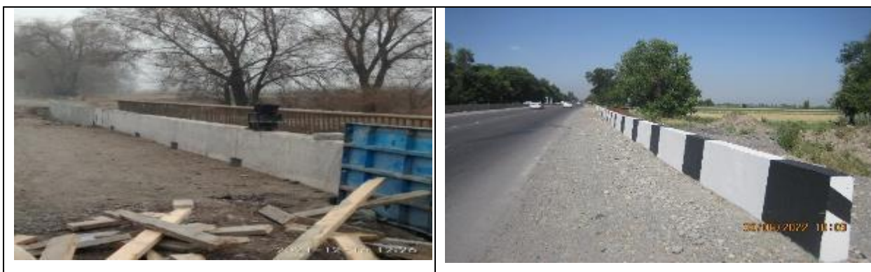
Рисунок 11 Строительство колесоотбойного парапета на р. Джеламыш
