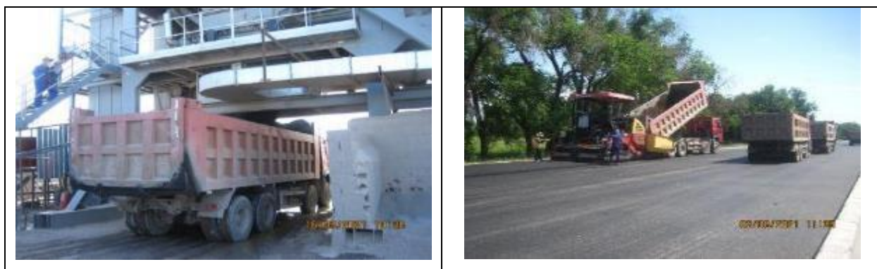
Рисунок 23 Загрузка асфальтовой смеси в самосвалы и выгрузка ее в асфальтоукладчики.
